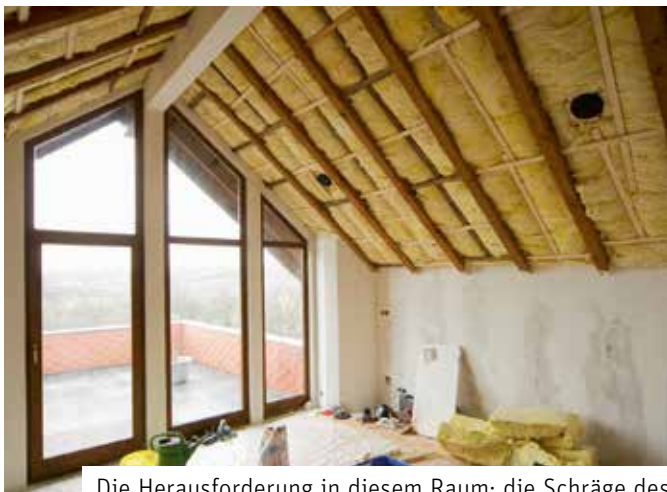
Die Herausforderung in diesem Raum: die Schräge des Daches, die eine passgenaue Anbringung der neuen Spanndecke verlangt. (Foto: epr/PORTAS)
